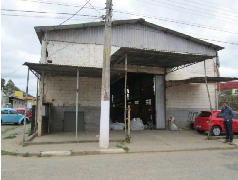
Figura 32: Galpão de Triagem da Associação Cata Papel
