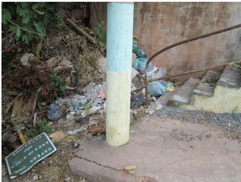
Figura 25: Ponto de descarte irregular de RCC, em frente à Santa Casa
