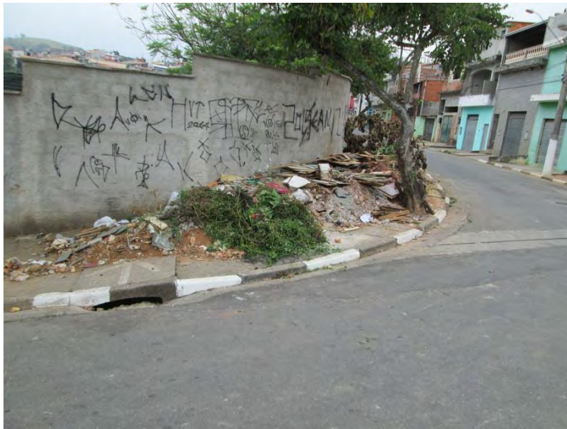
Figura 24: Ponto de descarte irregular de RCC, Av 14, Jardim Novo Éden.
