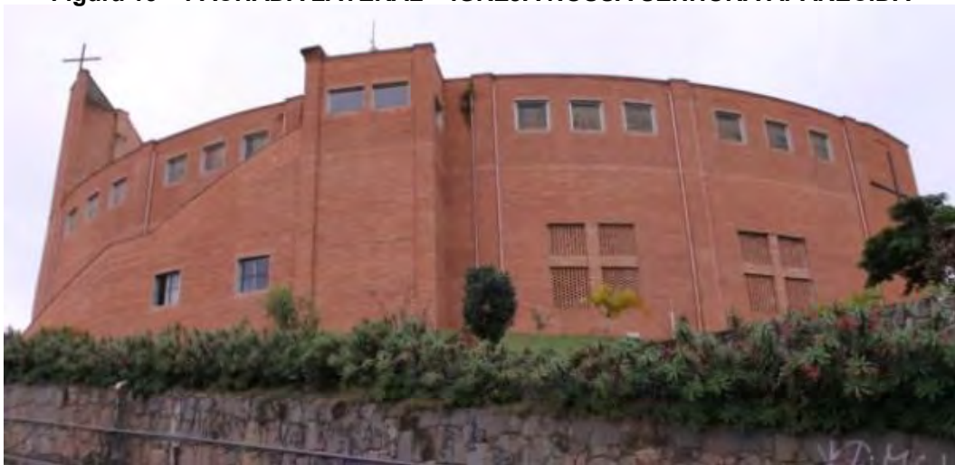
Figura 13 – FACHADA LATERAL – IGREJA NOSSA SENHORA APARECIDA
